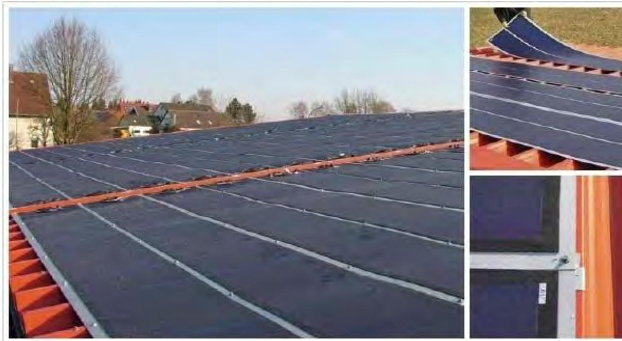
Sistema di copertura fotovoltaica per tetti industriali o tetti di grandi dimensioni
